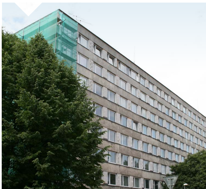
BYTOVÝ DŮM V KOLÍNĚ, UL. MASARYKOVA - V PRŮBĚHU REVITALIZACE
