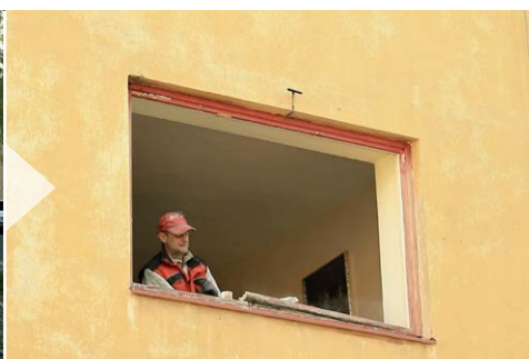
2 Demontáž stávajících výplní
