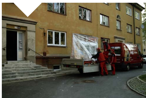
1 Příjezd k zákazníkovi a příprava na montáž
