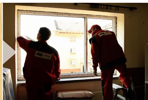
3 Montáž nové otvorové výplně (rámu výplně)
