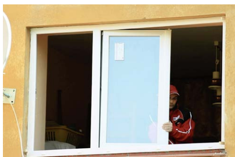
4 Osazení křidel otvorové výplně
