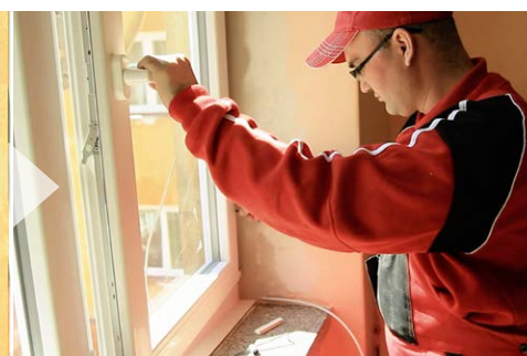
9 Seřízení nově namontovaného výrobku
